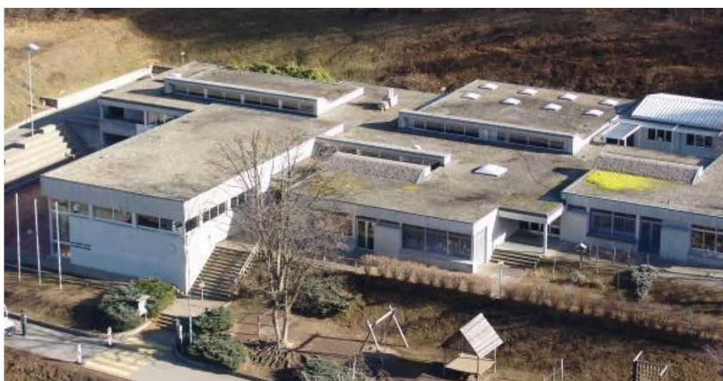
Centro scolastico Alto Malcantone, Scuola elementare
